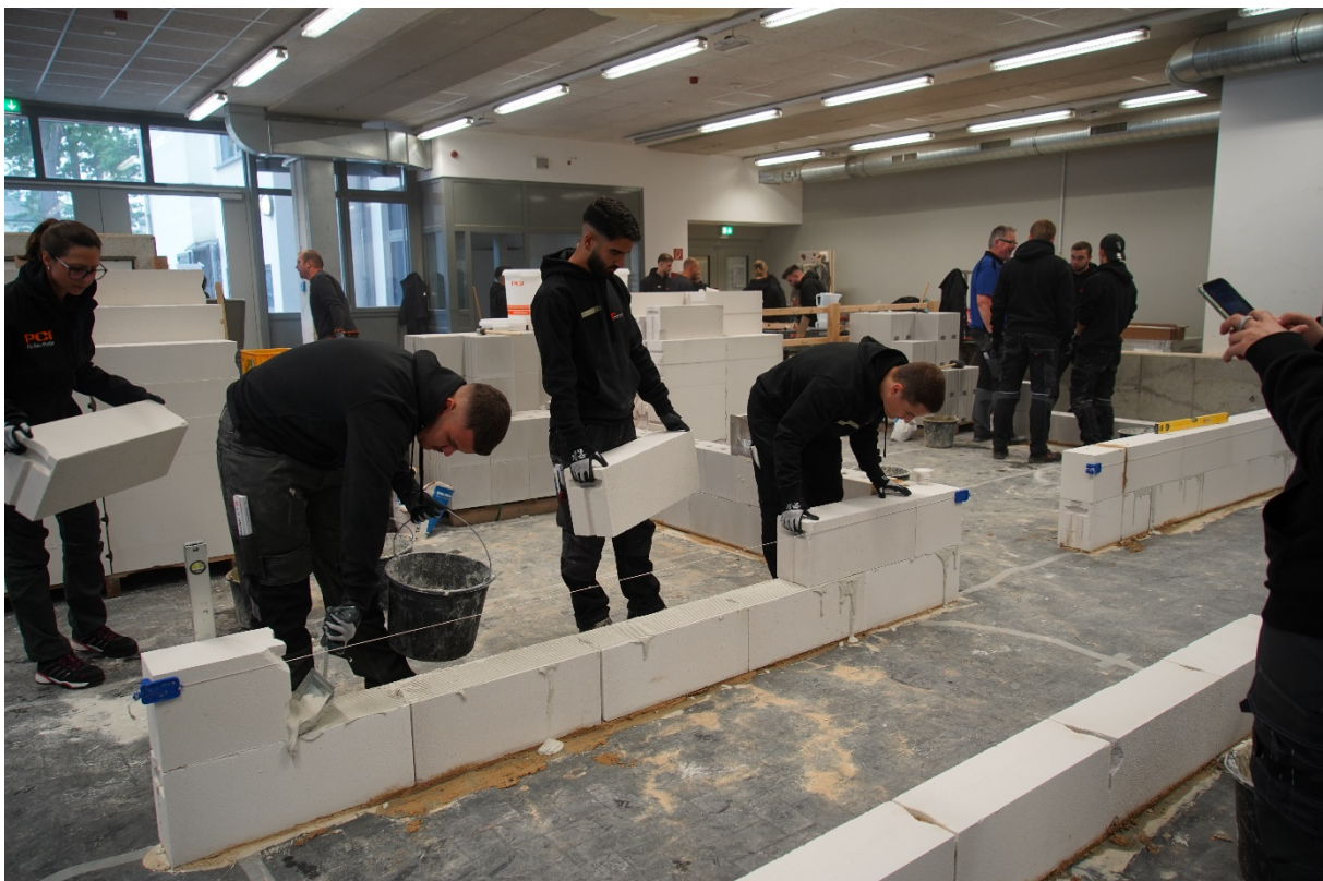
(Foto: BAUEN+LEBEN) Unsere Azubis beim Mauern von Kalksandsteinen und Porenbeton mit Dünnbettmörtel und Normalmörtel.
